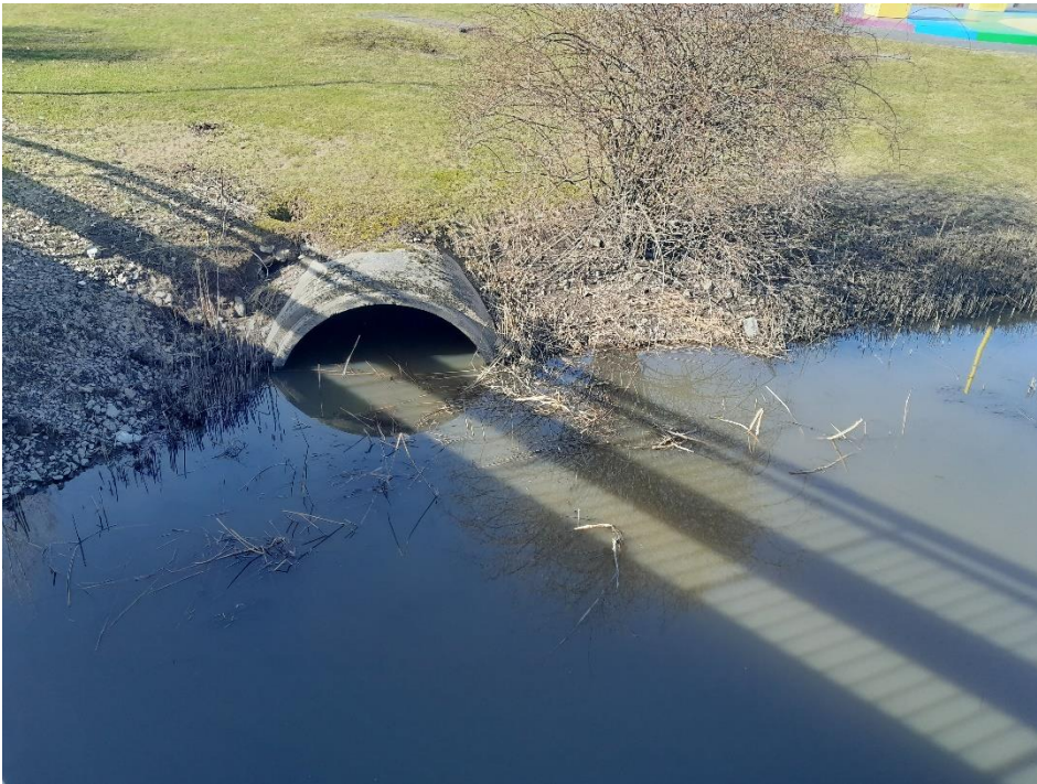
Figur 5. Dagvattenutlopp på Kvillebäckens västra sida, i DP2
